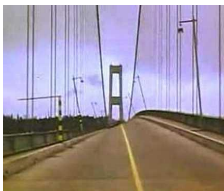
Ressonância ponte de Tacoma
